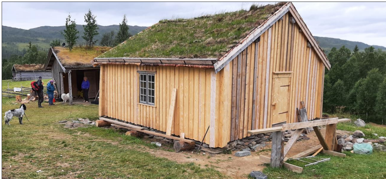
Istandsetting av seterstue fra 1870-tallet på Rømmervasseteren, Kvelia i Lierne kommune, Trøndelag. Finansiert av Kulturminnefondet og Utvalgte kulturlandskap, og gjennomført ved et omfattende dugnadsarbeid. Setra har et lite antall melkekyr og drives som besøksseter med servering av seterkost. Fra Kvelia utvalgte kulturlandskap. Foto: Ottar Bergli
